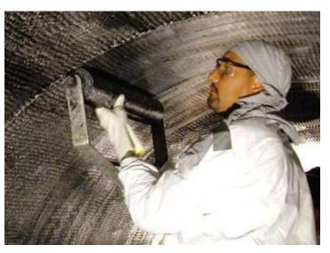
de tubería fatigada. Este método permite la aplicación posterior de cualquier tipo de recubrimiento contra factores químicos como ambientales.
