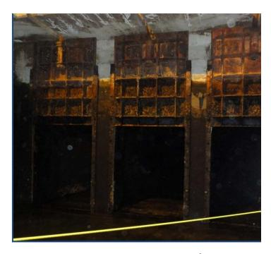
A través de la correcta elección de compuertas, de trabajos de rehabilitación y de la implementación de mejoras, es posible aumentar la eficiencia, así como monitorear y controlar las compuertas desde un centro de control a fin de facilitar su operación, ya sea para realizar trabajos de mantenimiento o para regular el flujo.
