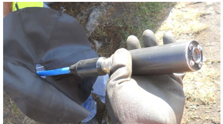
Instalación del sensor acústico
