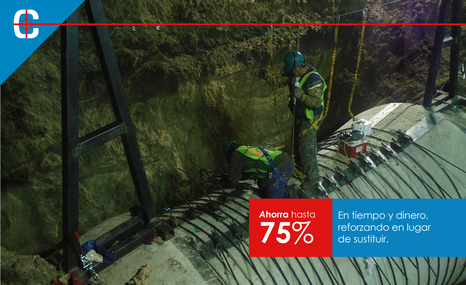
Colocación de tendones
