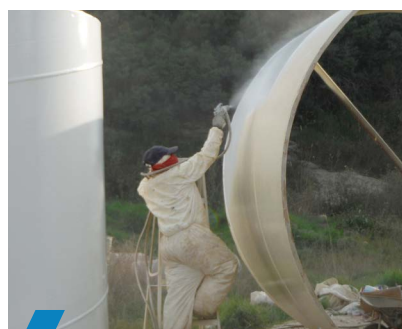
Recubrimiento contra corrosión
