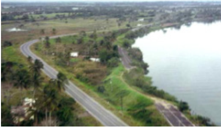
Afectación de carretera por socavación en la margen del
