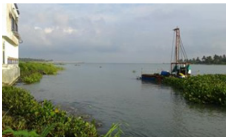
Geotecnia en presencia de agua
