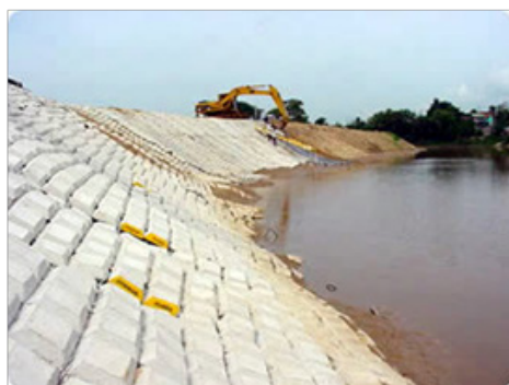
Protección de taludes con tapetes de concreto
