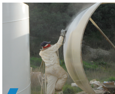
Recubrimiento contra corrosión
