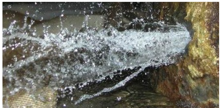
Tubería con corrosión de espiras
