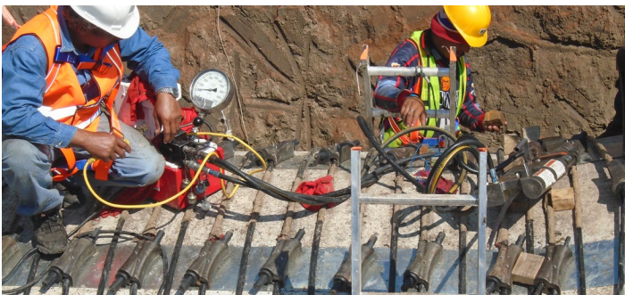
Colocación de tendones
